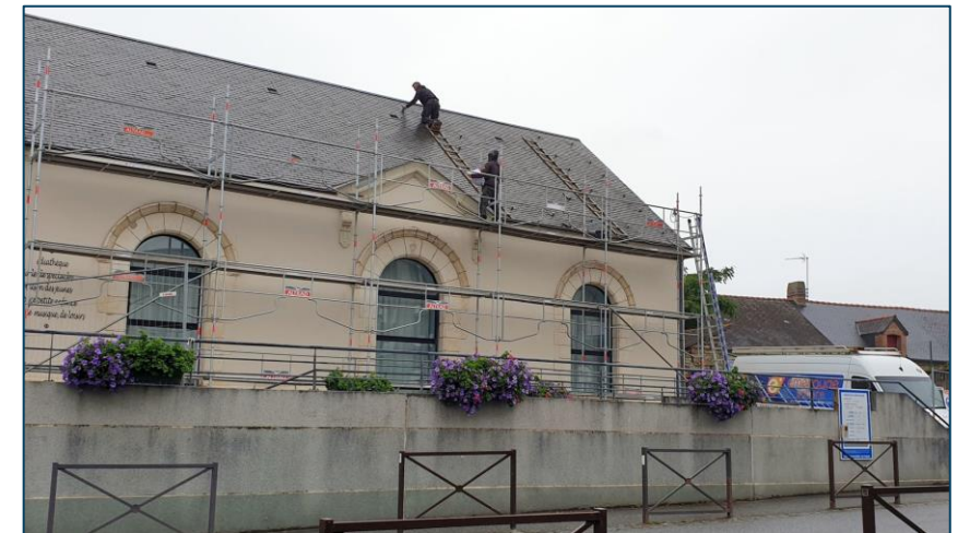
LAILLÉ - Centrale photovoltaïque de 33 kWc
