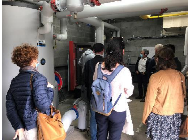
Chaufferie bois de Lailé
