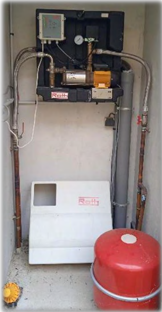
DISPOSITIF MAIRIE 4500 L ENTERRÉS => SANITAIRES
