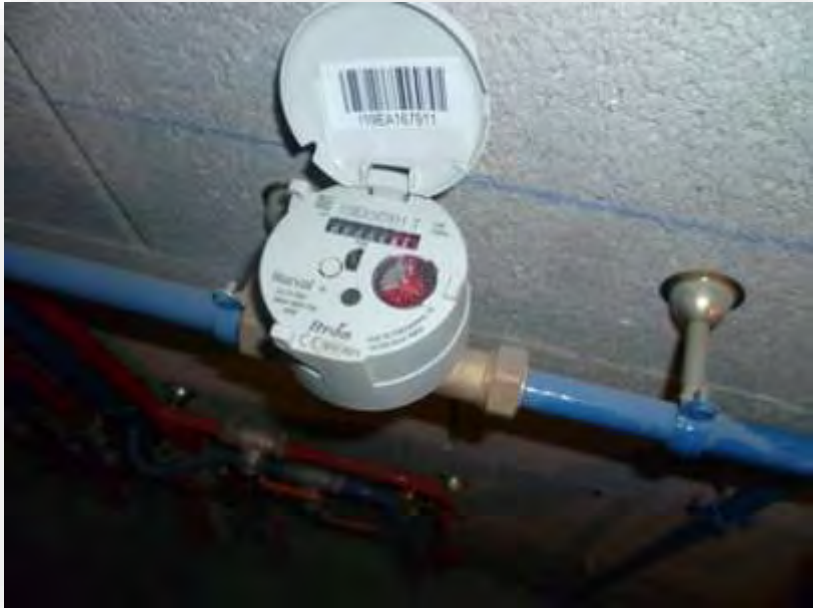
Compteur eau de pluie
