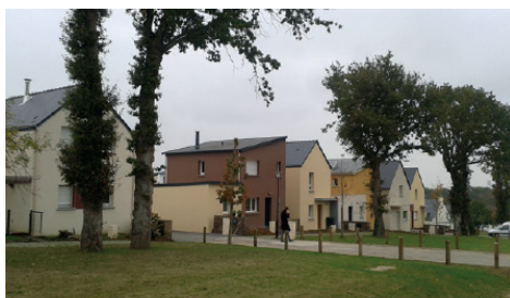
Front urbain, quartier Haute Abbaye, Vern-sur-Seiche
