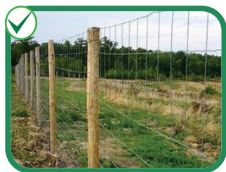
Clôture grillage à mouton poteaux châtaignier / grillage métal à mailles carrées ou rectangulaires.
