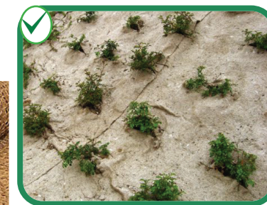
Toile de paillage biodégradable disposée dans un talus
