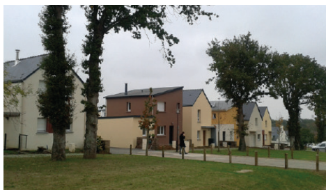
Front urbain, quartier Haute Abbaye, Vern-sur-Seiche
