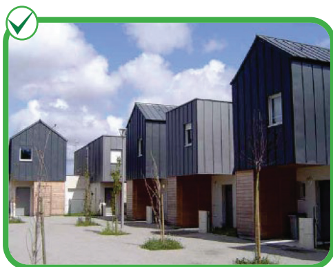
illustration de volumes associés à un matériau Quartier de la Bottière Chesnaie, Nantes (
