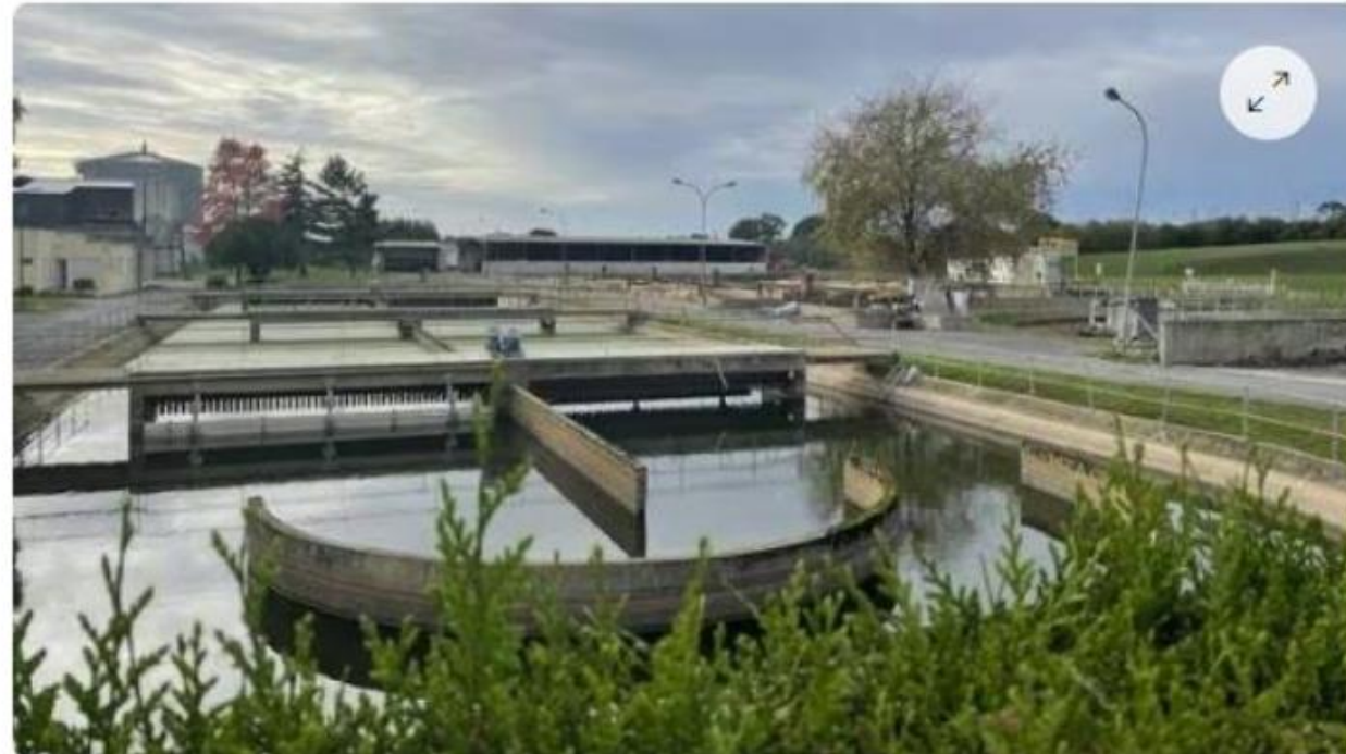
Les eaux usées de la station d'épuration de Calouët, à Loudéac, seront bientôt recyclées. | OUEST-FRANCE
