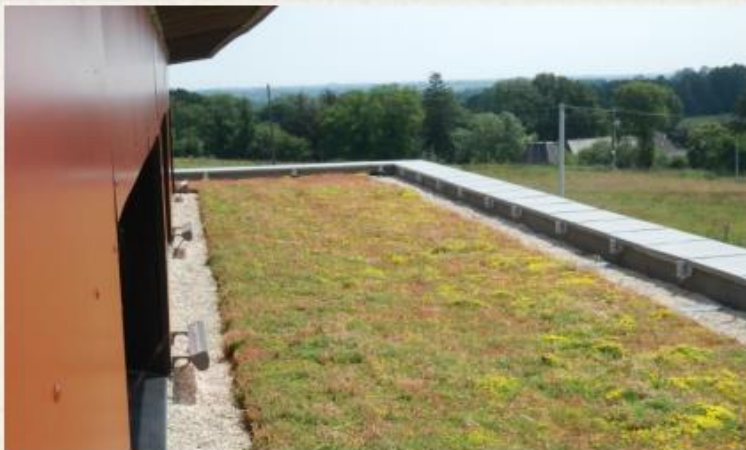
Val d'Ille-Aubigné (35) : une toiture végétalisée sur le pôle communautaire
