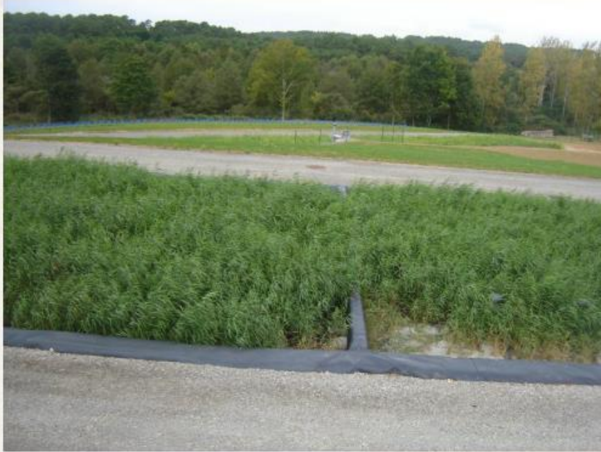
Saint-Dolay (56) : une step à à filtres planté de roseaux
