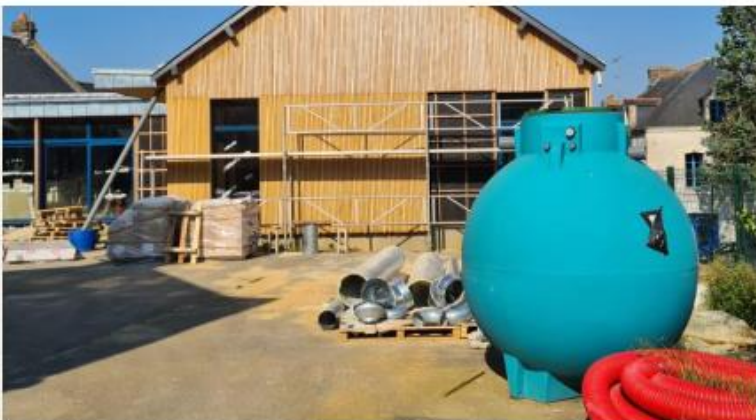
Couesnon Marches de Bretagne / Bazouges la P. (35) : récupération d'eau de pluie pour la médiathèque
