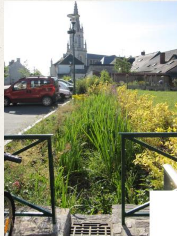
Mordelles (35) : une noue paysagère d'infiltration
