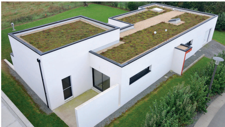
► La végétalisation des toitures terrasses sera recommandée
