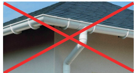
Gouttières rapportée interdite
