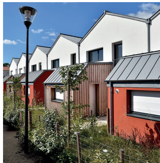
Clôtures grillagées Clisson - Les Allées de Kleis
