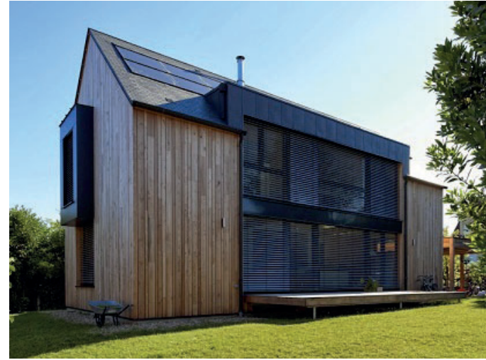
Intégration des panneaux solaires et du conduit de cheminée Maison lenté - agence KARAWITZ
