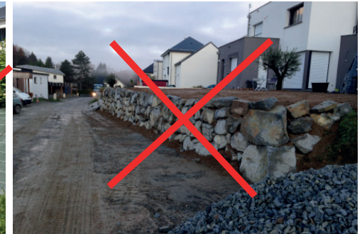
► Les enrochements sont interdits
