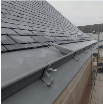
Gouttières à la nantaise en zinc
