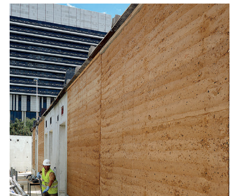
Mur en terre crue
