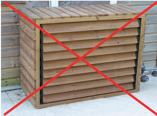
Habillage de la pompe à chaleur en extérieur : interdit
