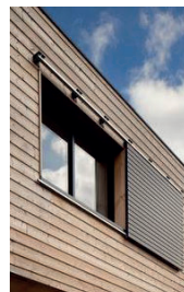
Volets extérieurs mobiles
