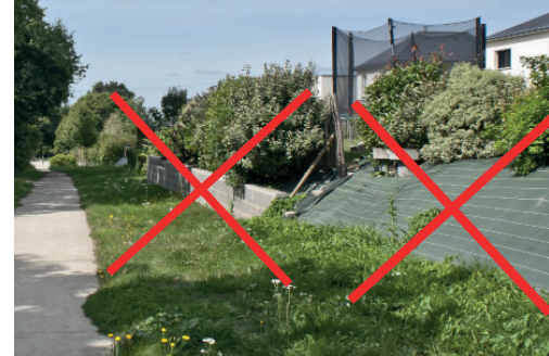
► Traitement de soutènement interdit
