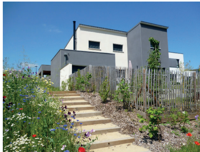
Traitement de la limite de lot avec ganivelle ZAC du Tertre à Domloup
