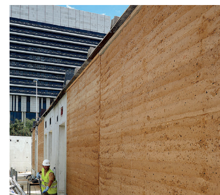
Mur en terre crue
