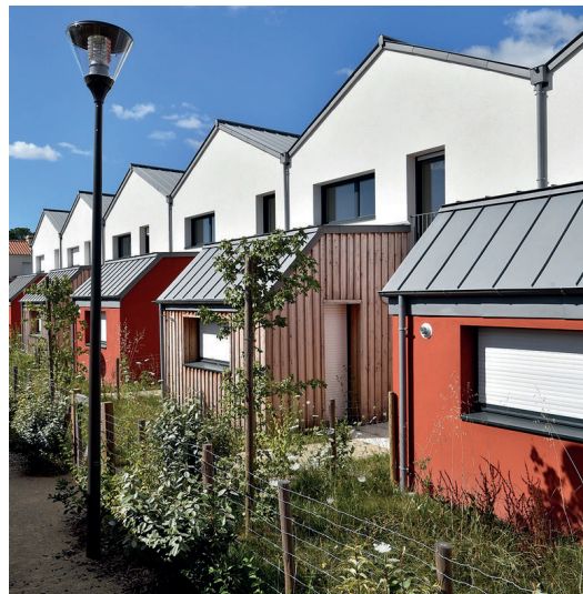
Clôtures grillagées Clisson - Les Allées de Kleis
