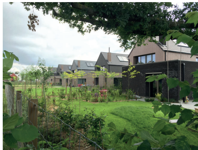
Côté Nature, Quartier résidentiel & Parc paysager / Sainghin en Mélançois - Architecte : HORNOY Architectes
