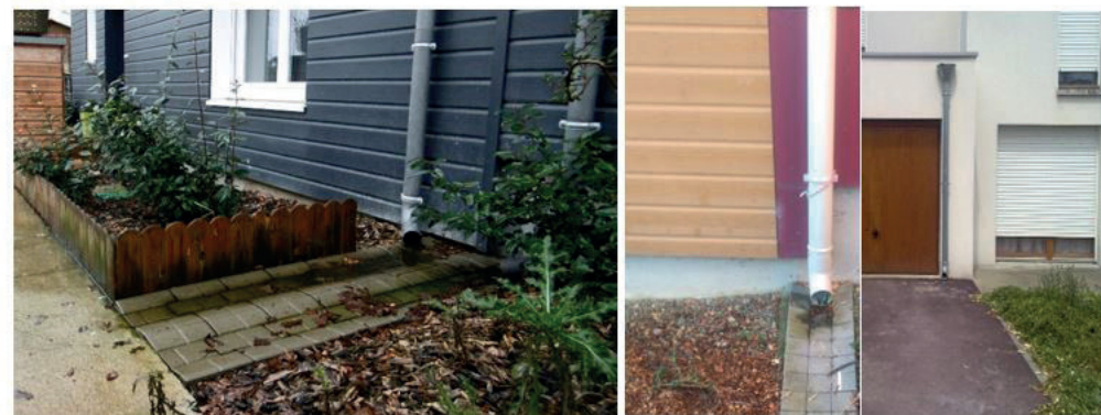
Exemples de raccordement d'écoulement sur parcelles privées avant rejet vers une voirie.
