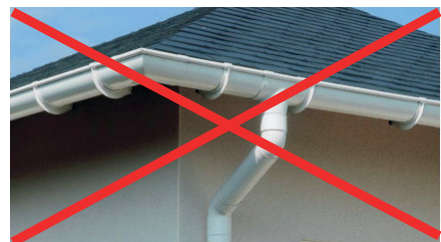
Gouttières rapportée interdite
