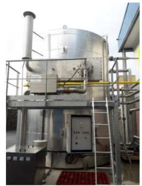
Fig. 1 : Ballon de production d'eau chaude par brûleur immergé et récupération de chaleur par stratification
