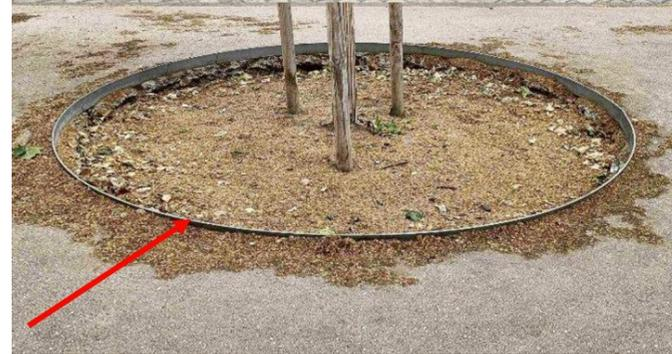
Quelques mm d'obstacles, ou une mauvaise pente, suffisent à créer des problèmes de ruissellements...
