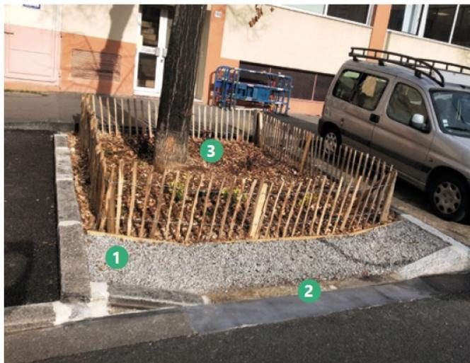
Résultat : 100 m<sup>2</sup> de surface sont déconnectés du réseau d'assainissement pour toutes les pluies de faible intensité. La déconnexion est également efficace pour certains événements estivaux caractérisés par des pluies courtes et intenses. Par exemple, dans le cas des arbres de pluie de la rue Vauban, 3,5 mm de hauteur d'eau ont été infiltrés en 6 minutes sur un sol sec et jusqu'à 7 mm en 6 minutes sur un sol humide.
