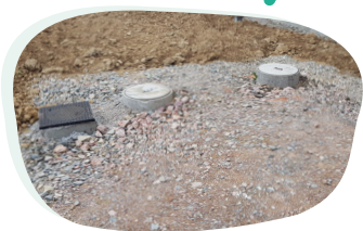
Regards de la cuve
