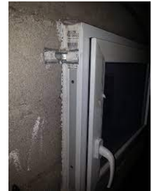
Isolation par l'intérieur
